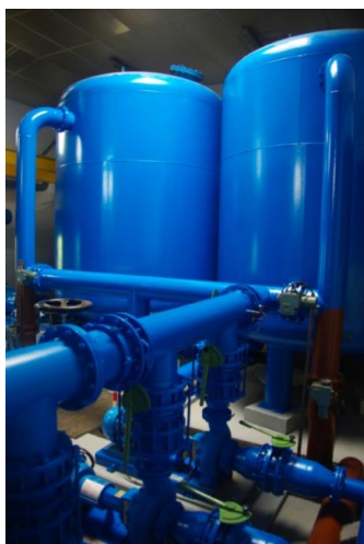
Filtration sur charbon actif dans l'usine des Bîmes
